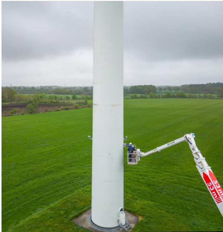
Anbringung über Magnete oder Spezialkleber für Windenergieanlagen
